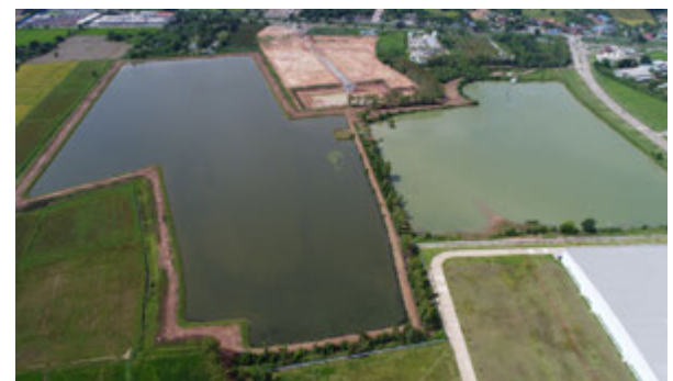
โครงการสร้างอ่างเก็บน้ำดิบเพิ่ม WHA SIL
